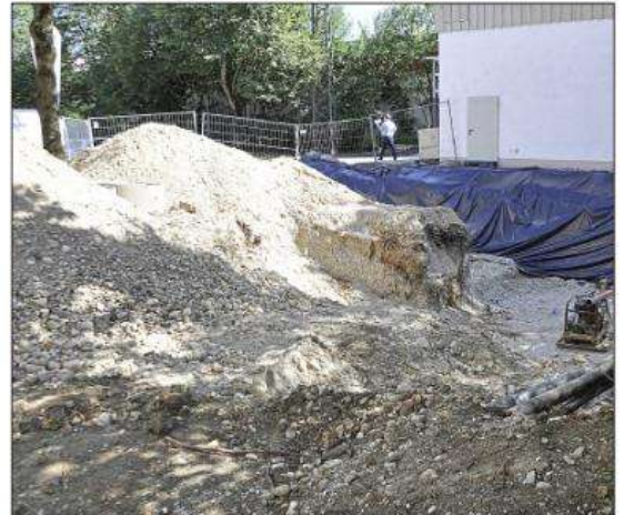
Die Ehrenamtlichen des THW haben die Grube schon ausgebaggert.
