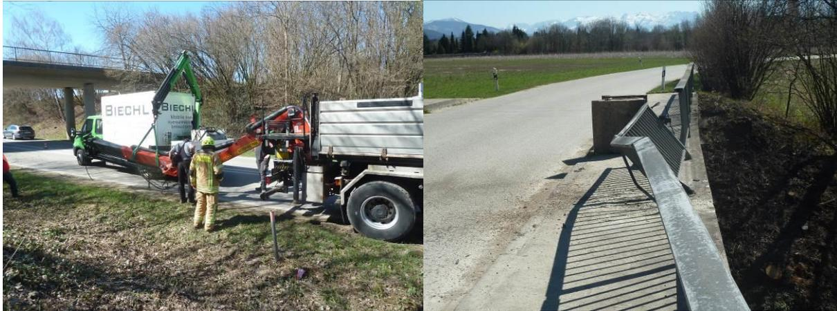
Ein LKW ist mit seinem Ladekran beim Befahren der BGL 2 an der darüberführenden Brücke nach Eham hängengeblieben. Dabei wurde der Kran nach hinten weg gebogen und erheblich beschädigt. Der Greifer des Ladekranes blieb im Geländer der Brücke hängen und wurde als Sofortmaßnahme gesichert und auf dem Gehweg abgelegt. Neben dem Kran wurde auch das Brückengeländer in Mitleidenschaft gezogen. Im Anschluß wurde der Ladekran von einer Fachfirma demontiert.
