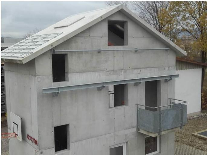
Am Übungshaus ist für die Erweiterung der Übungsmöglichkeiten im Bereich Absturzsicherung noch ein Stahlträger, wie er sich bei Industrieanlagen findet mit darüber liegender Sicherungsstange angebracht worden. Konstruktion, Bau und Montage sind wie in den meisten Fällen bei der Feuerwehr Freilassing in Eigenleistung erbracht worden.
